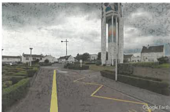
Château d'Eau (Blériot – Collège)
