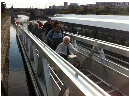
Respect de la réglementation d'accessibilité des PMR : allongement de la passerelle en fonction des différences de niveaux entre le quai et le plan d'eau pour rester dans la limite des 4 / 5% de pente; les pontons étant flottants ils s'adaptent automatiquement aux variations du niveau de l'eau, n'affectant donc pas l'accessibilité PMR
