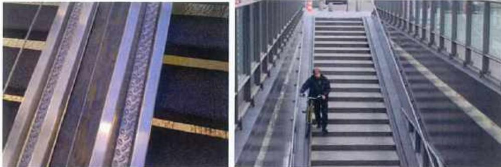
*Rail permettant de faciliter le transport des vélos sur les escaliers (source : 2EI)*
