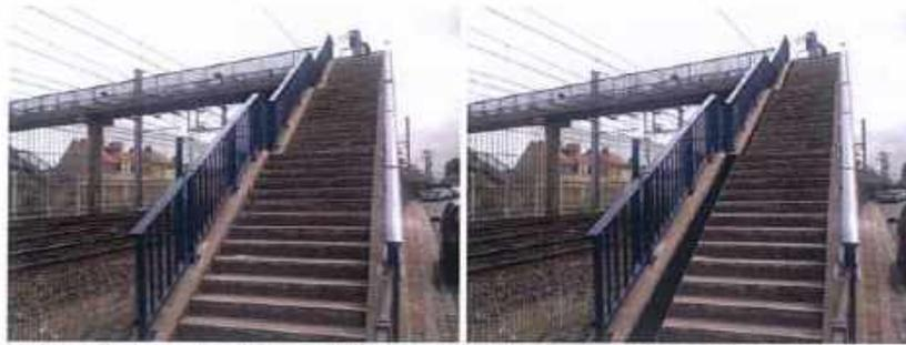
*Ouverture de la rampe de la gare des Fontinettes aux cyclistes et pose d'un rail en U d'environ 10 cm de large permettant de pousser le vélo à la montée avec un minimum d'effort*
