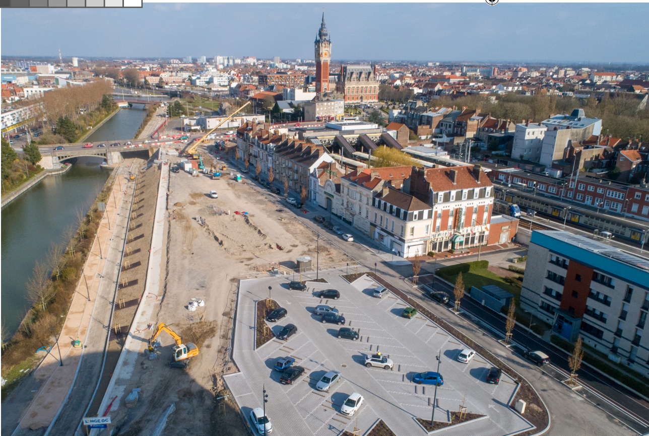
Vue aérienne du parking du PEM (mai 2021)
