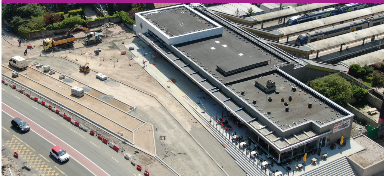
Vue aérienne du chantier du parvis de la gare (mai 2021)
