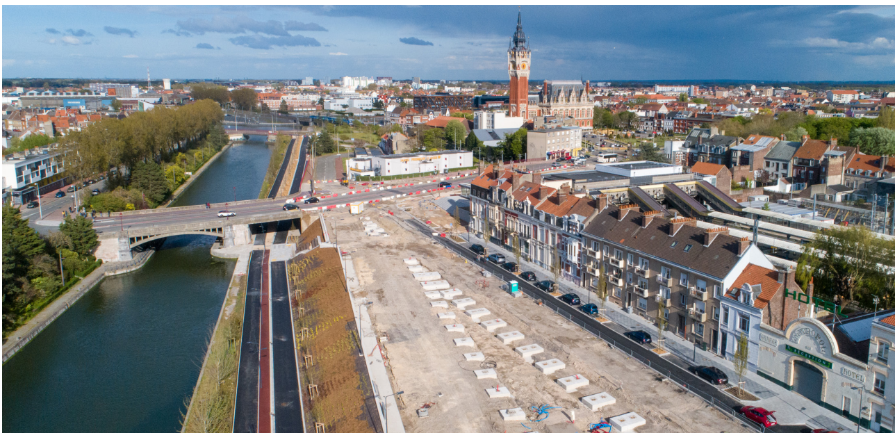
Vue aérienne des fondations des marquises (mai 2021)
