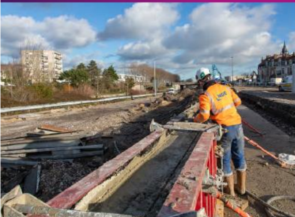
Construction d'un mur de soutènement en crête du talus pour la voie bus de la gare routière Décembre 2020
