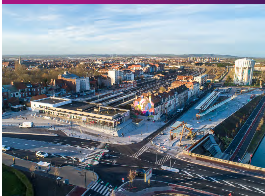
Chantier du Pôle d'Echanges Multimodal Janvier 2022
