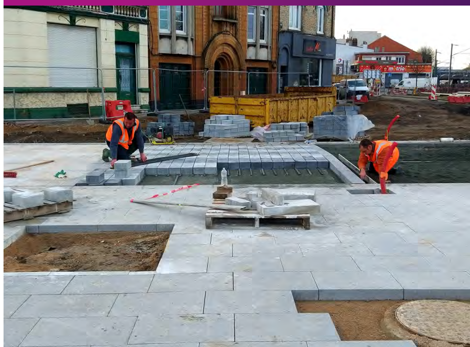
Création de la placette quai Andrieux Décembre 2020
