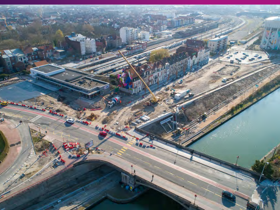
Chantier du Pôle d'Echanges Multimodal Mars 2021
