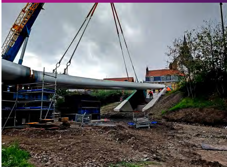
Pose du 3 ème tronçon 24 Octobre 2019
