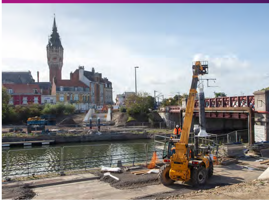
Implantation des poteaux d'appui Eté 2019
